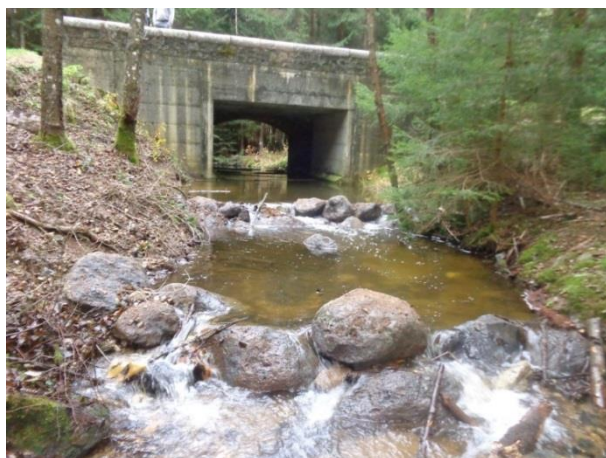
Aménagement pour franchissement d'obstacle
