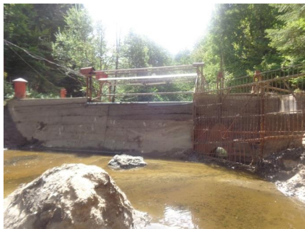
Vidange curage du barrage de Ludon
